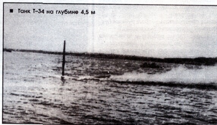
■ Танк Т-34, предназначенный для подводного хождения
