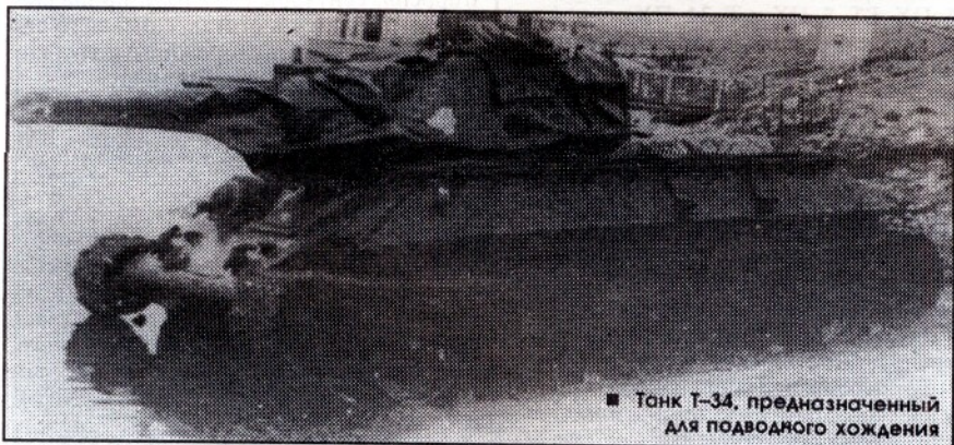
■ Вход в воду танка Т-34, предназначенного для подводного хождения
